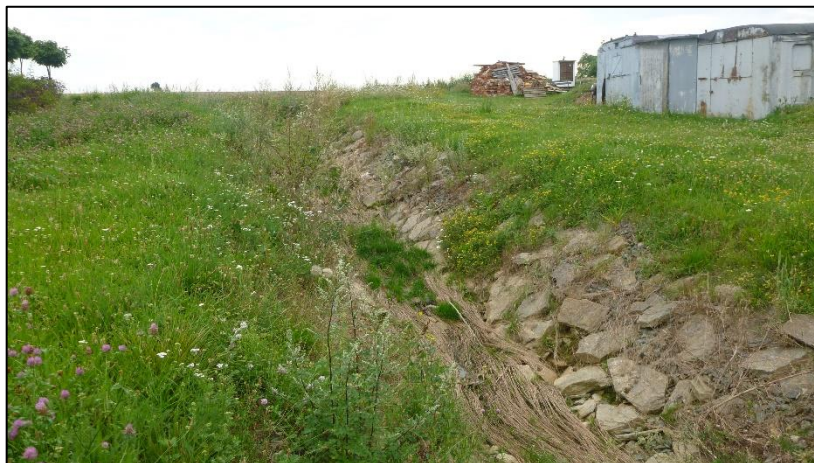
Obr. 30 Koryto vtokového objektu – horské vpusti – posun kamenné rovnaniny
